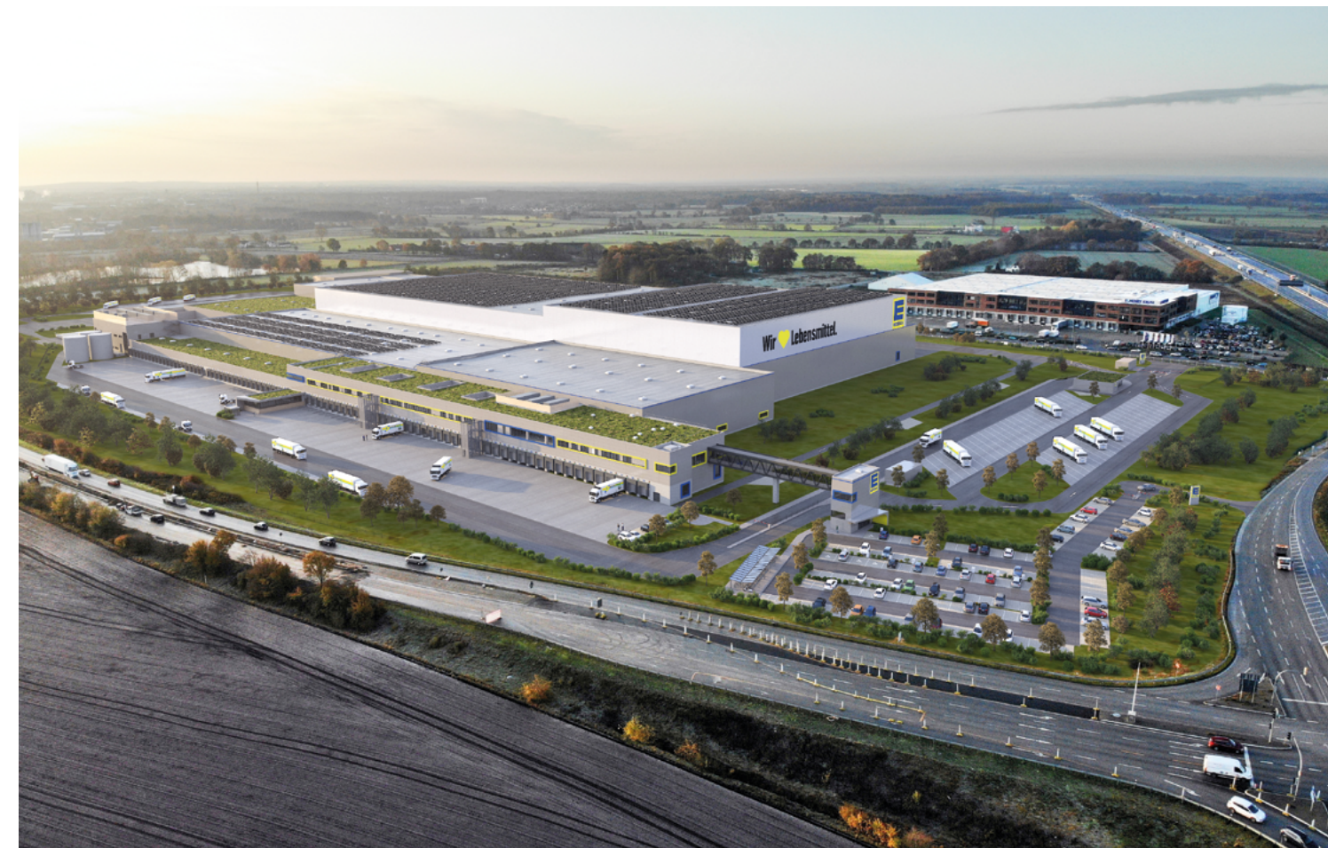
Das Gelände der Zentrale von EDEKA Nord in Neumünster
